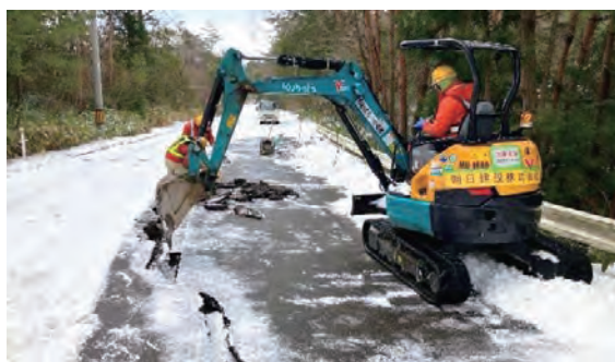
道路啓開作業(能登町)
