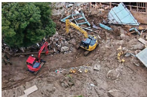
九州北部豪雨災害 応急復旧作業
