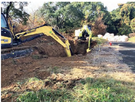
防護服等の埋却掘削作業
