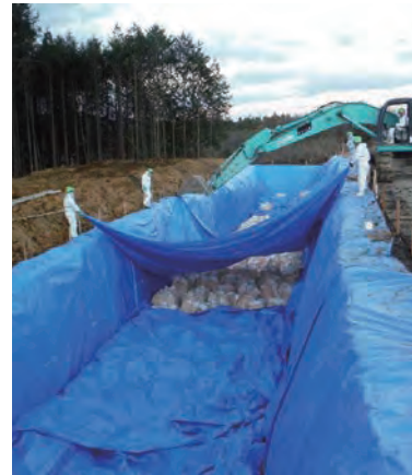
作業終了時のブルーシート設置
