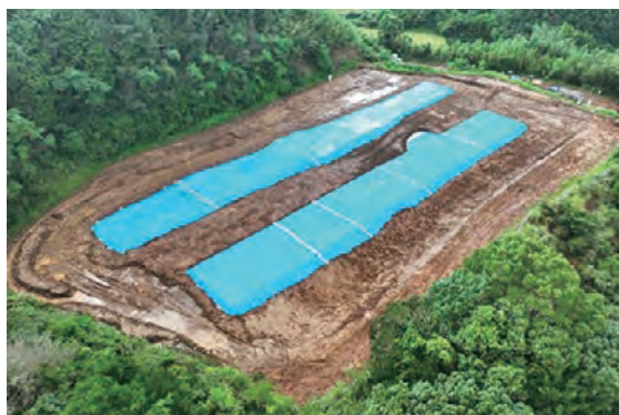
豚熱防疫 R5.9.21 埋却作業完了
